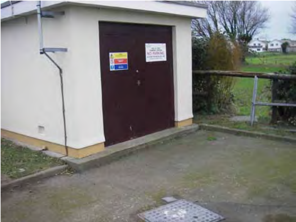
Figure 21. Rue du Pont Pumping Station
